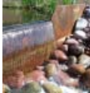
Fördämningar av cortenstål.
