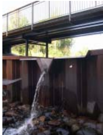
Utloppet från Pylonendammen
